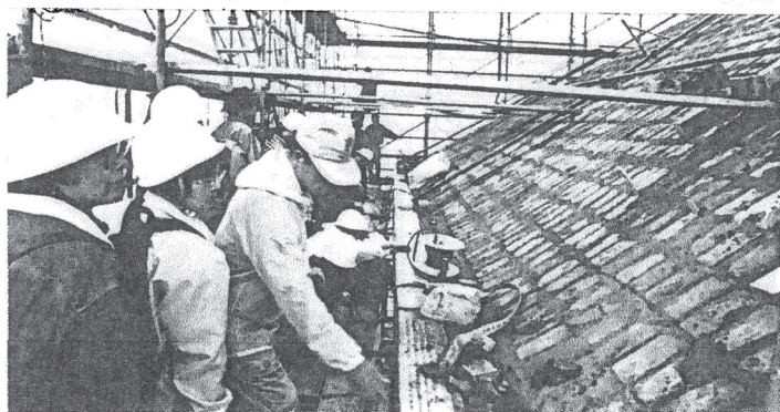
③電車通り側に向いた、2階屋根瓦の復元作業現場を熱心に覗き込む会員ら＝現郷土資料館で
