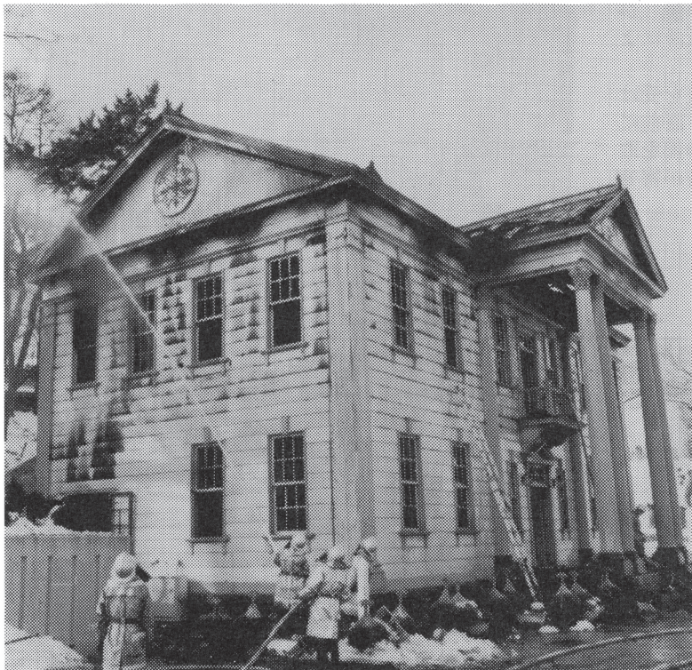
くすぶり続ける旧渡島支庁々舎の火災
