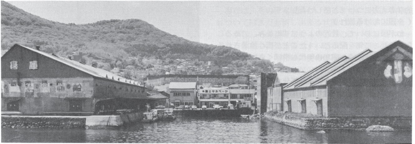
青函博会場に予定されている「緑の島」の加橋工事でなくなる「はしけ澗」 — 函館市大町
