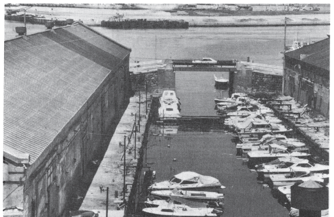
はしけ澗をまたぐ七財橋のある風景も湾岸道路工事で埋立てられる
